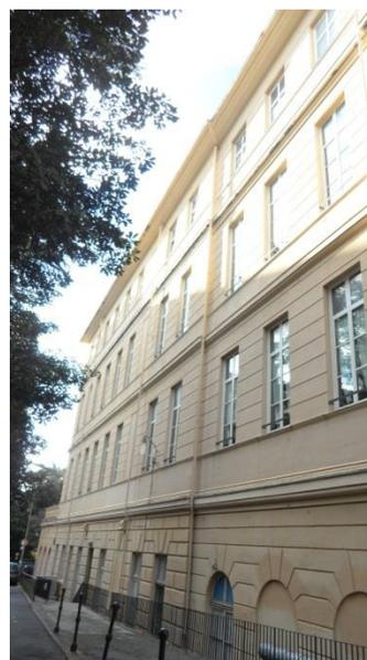
Il solaio tra piano terra e interrato è costituito da voltine con travi in acciaio e mattoni pieni o forati. Il piano terzo è frutto di una successiva sopraelevazione risalente agli anni 60. Come visibile dalle termografie, la struttura del piano sembra essere realizzata a telaio con travi e pilastri in c.a. e tamponamenti in muratura piena o semipiena.
